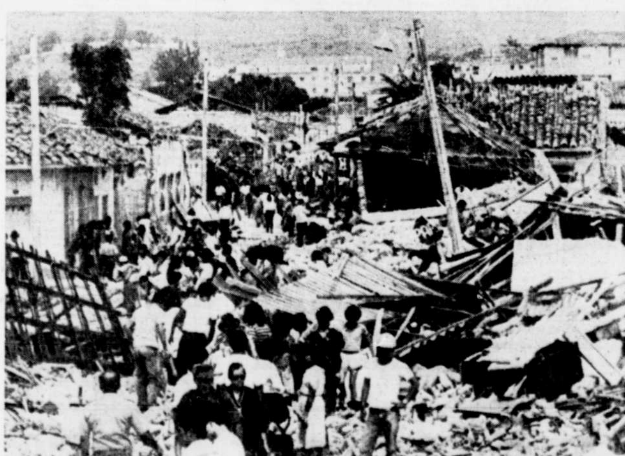
Les habitants de Popayan circulent à travers les débris à la recherche de survivants, ne sachant trop que faire pour se procurer de quoi boire et manger.
