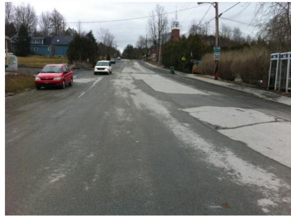
Figure 10 : Surlargeur de la rue de l'Église
