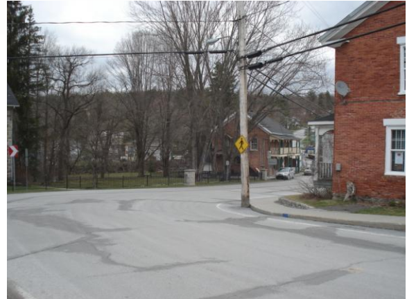
Figure 16 : Intersection de la route 237 et du chemin de Saint-Armand, manque de visibilité
