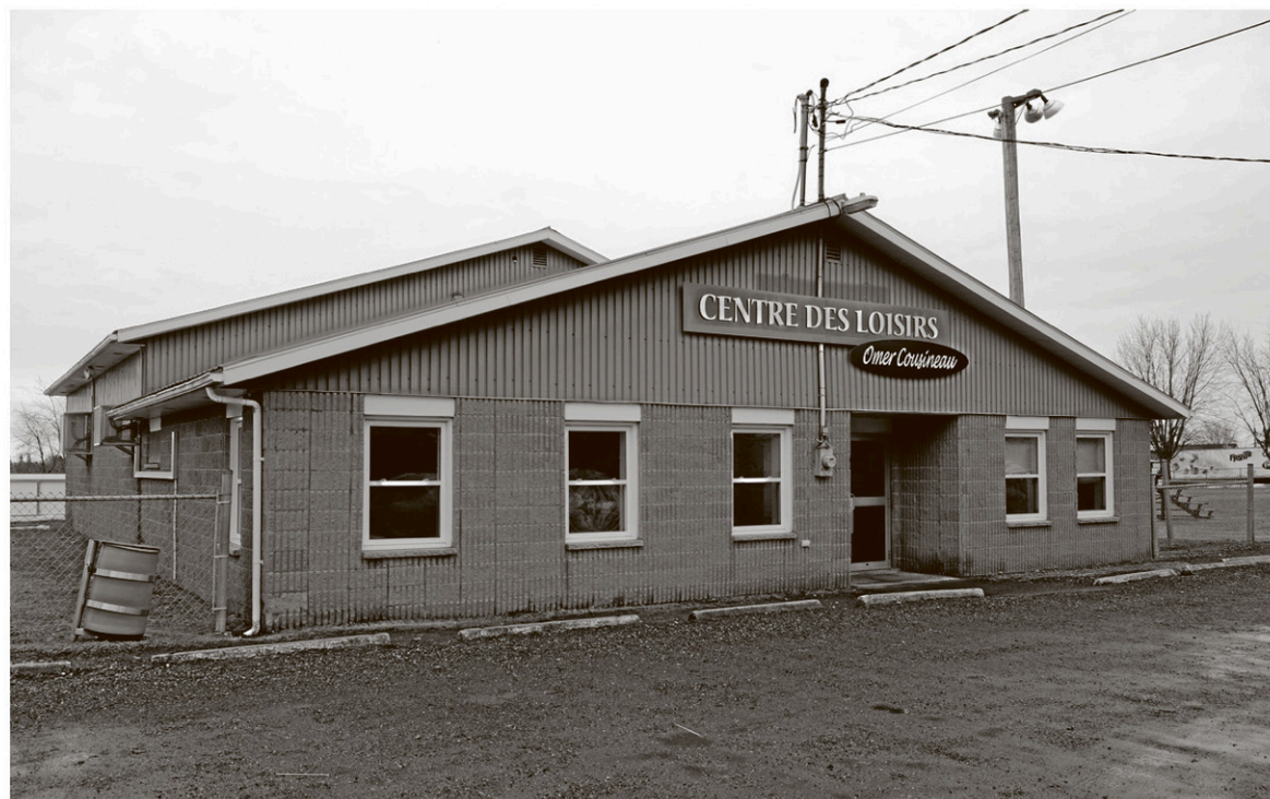
Conditionnellement à l'obtention de subventions, Rougemont compte démolir le centre de loisirs de la Grande-Caroline pour en construire un nouveau cette année. — PHOTO ALAIN DION
