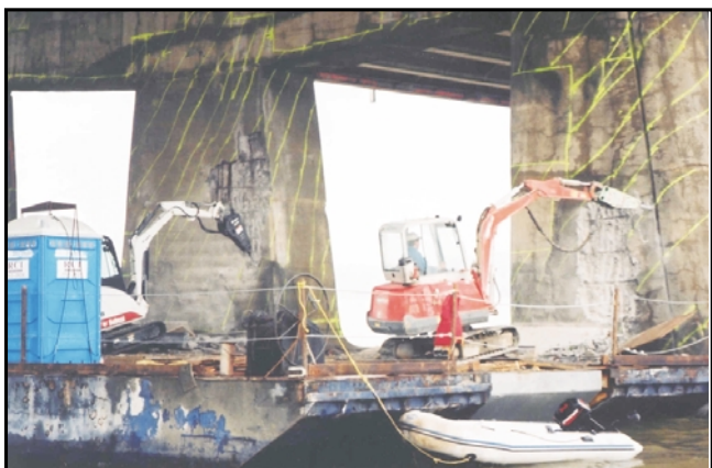
Une embarcation de sécurité doit être amarrée à chaque poste de travail.
