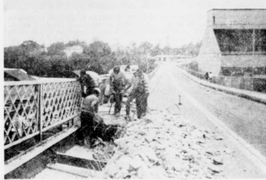
DEMOLITION — Quelques travailleurs sont à démolir le trottoir sur le pont Tascheau, à East Angus, afin de le refaire à neuf sur les deux côtés du pont. Ces travaux estimés à quelque $15,000 dureront un mois et demi environ, et emploient neuf travailleurs sous les ordres du contremaître Moïse Côté, de Victoriaville. (Photo La Tribune, par Mme G. Pomerleau)
