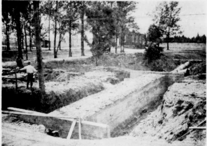
TRAVAUX — Des travaux de réfection et d'élargissement sont en cours actuellement en plein centre du village de St-Gérard. Ils s'étendent sur une longueur de près de deux milles, et compléteront différentes autres améliorations entreprises depuis une couple d'années dans ce secteur. Cette photo a été prise face à l'église paroissiale qui abrite également le sanctuaire de St-Gérard. (Photo La Tribune, par Studio Breton)
