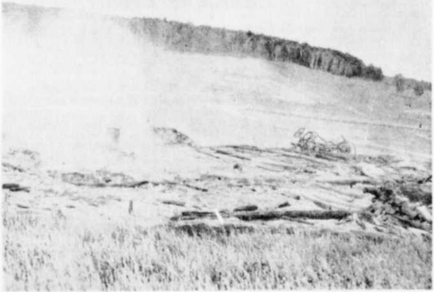
DESTRUCTION — Une résidence et une grange habitées par M. Hercule Fortin et propriétés de M. Roland Dostie ont été la proie des flammes hier à St-Méthode. Les deux bâtisses ont été rasées au sol.
