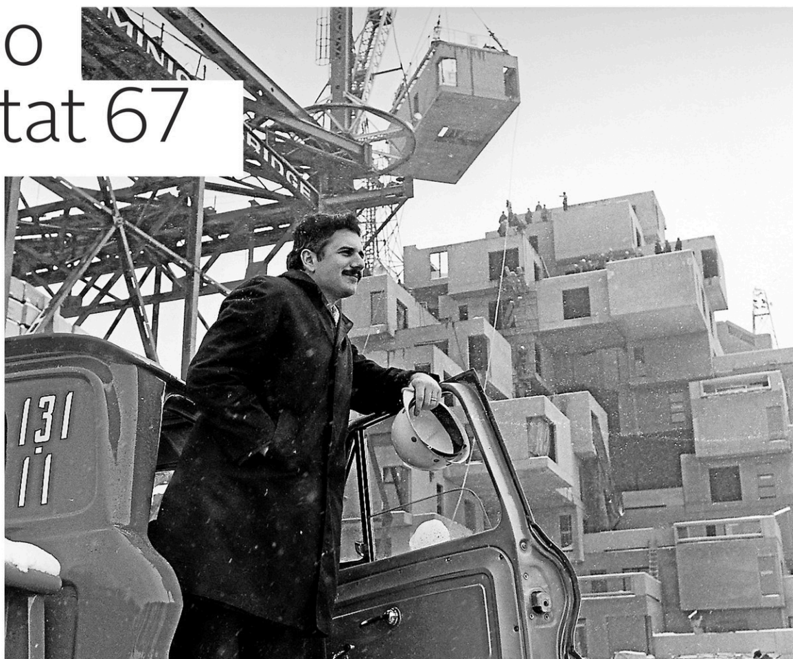
Moshe Safdie sur le chantier de son projet en 1966 — PHOTO TIRÉE DE LA COLLECTION OF SAFDIE ARCHITECTS
