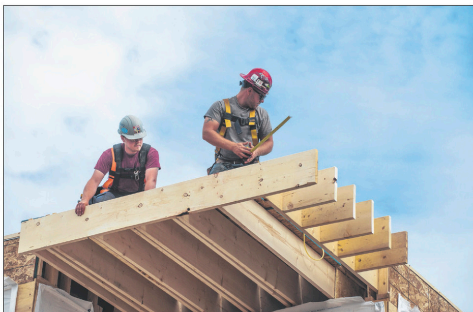
Joël Lanouette et Nicolas Lefebvre, qui travaillent sur le chantier du Complexe Grenier, seront en vacances pour les deux prochaines semaines.
