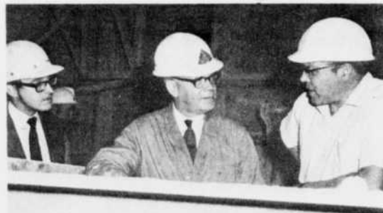
M. HORWOOD constate les améliorations apportées à ce générateur d'acide fluorhydrique, à l'usine de fluorure. De gauche à droite: MM. E. Darnedde, scientifique en développement des procédés chimiques, division Techniques; J.F. Horwood; H.R. Edwards, surveillant du procédé, section fluorure d'aluminium et séchage de l'hydrate.
