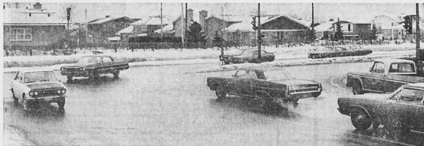
La rue Jarry doit s'arrêter devant la clôture qui ceinture le territoire de Ville Mont-Royal. Cet obstacle a nécessité la construction d'un tunnel, véritable gaspillage d'argent.
