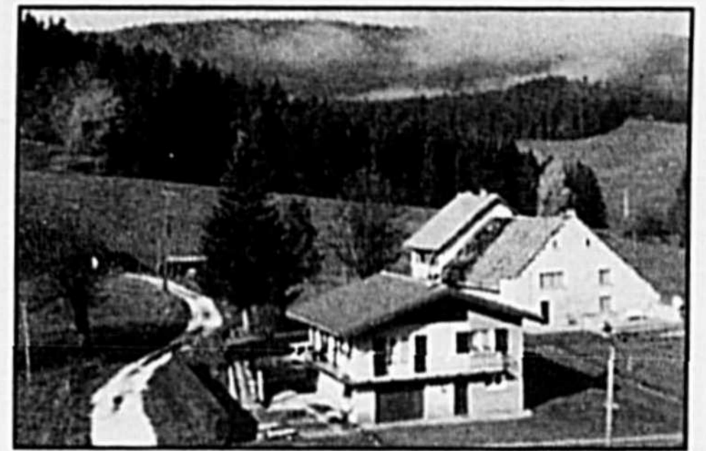
Dans le Parc naturel du Vercors, on offre des programmes d'aide pour l'intégration de nouvelles bâtisses dans les paysages locaux.
