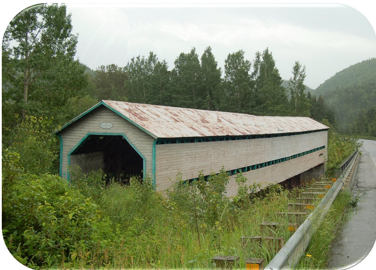
Pont Coulée-Carrier, Saint-René-de-Matane
