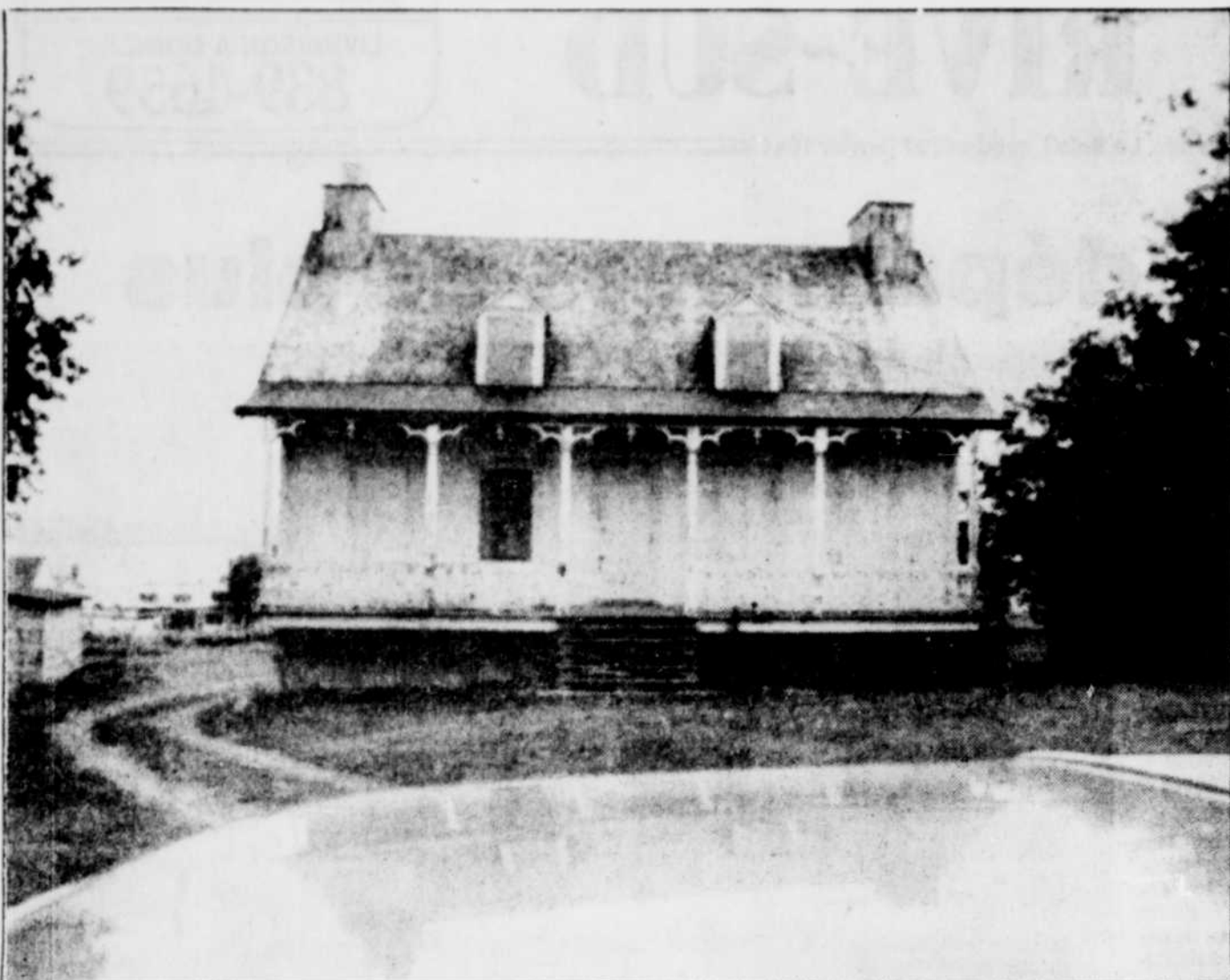
La maison Tessier, dit Laplante, située dans le secteur Courville, sera restaurée pour les fêtes du 350e anniversaire de Beauport.
