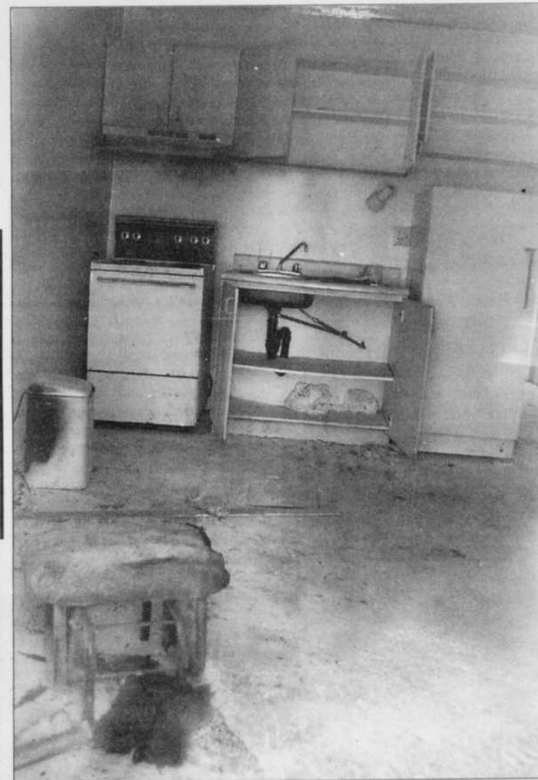
Mis à part le four et quelques armoires, le logement ne contenait aucun meuble. L'explosion, imputable au naphta, a sérieusement abîmé la cuisine.
