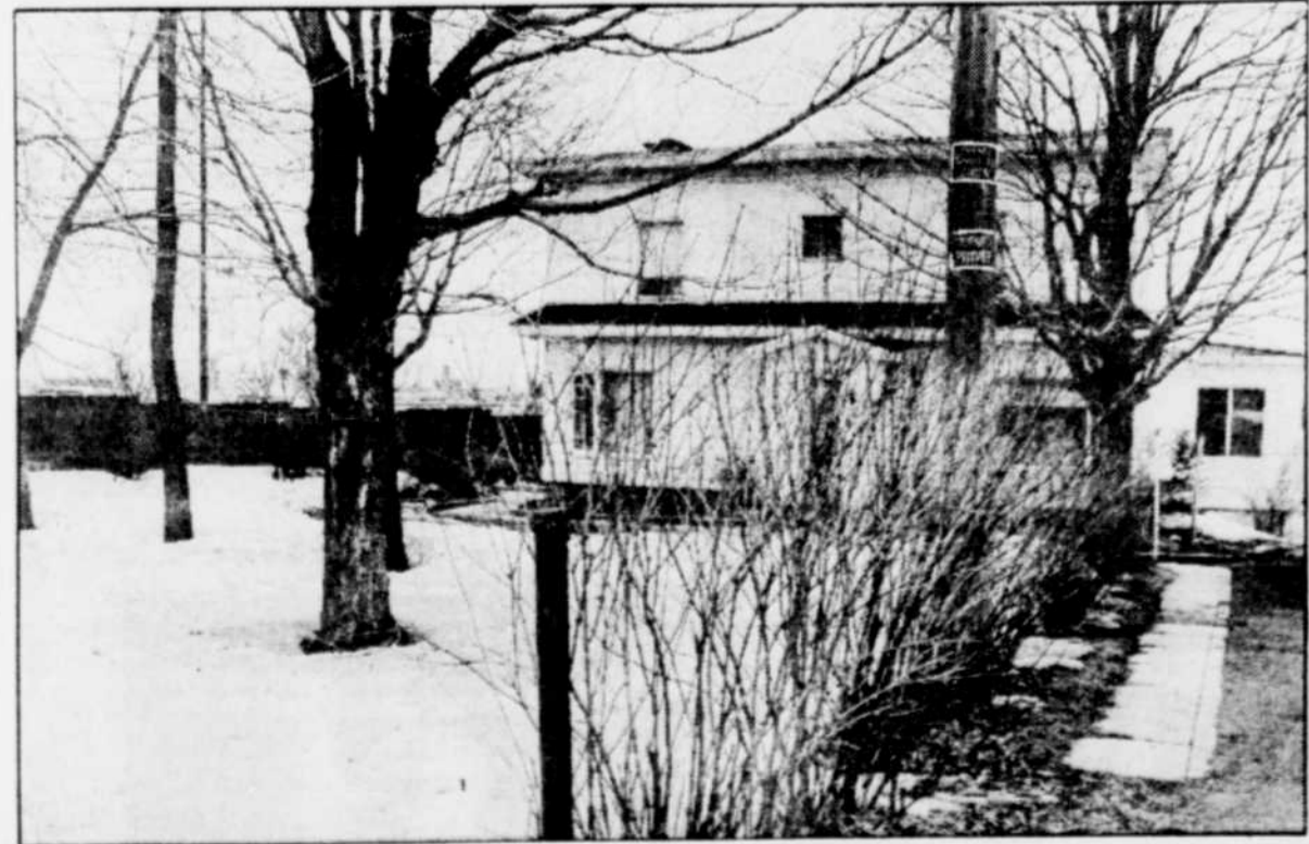
La propriété des Latendresse, à Lauzon, se trouve dans le tracé des conduits de déviation des eaux usées de Lévis et de Lauzon. Le propriétaire croit que l'on fera un tort irréparable aux arbres centenaires.
