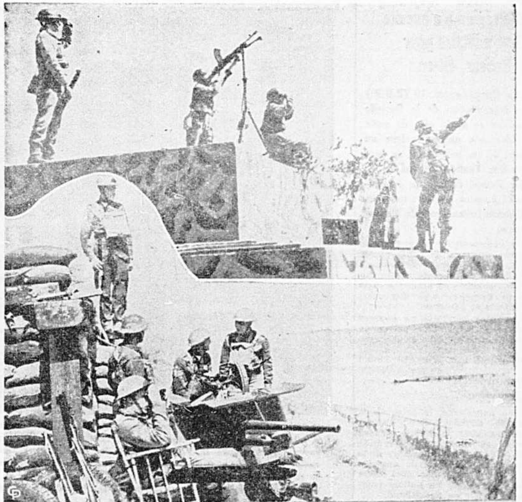
Une surveillance constante est exercée sur les bords des côtes de la Grande-Bretagne et tout appareil allemand qui tente de se diriger vers l'intérieur du pays y est accueilli par un feu nourri.
