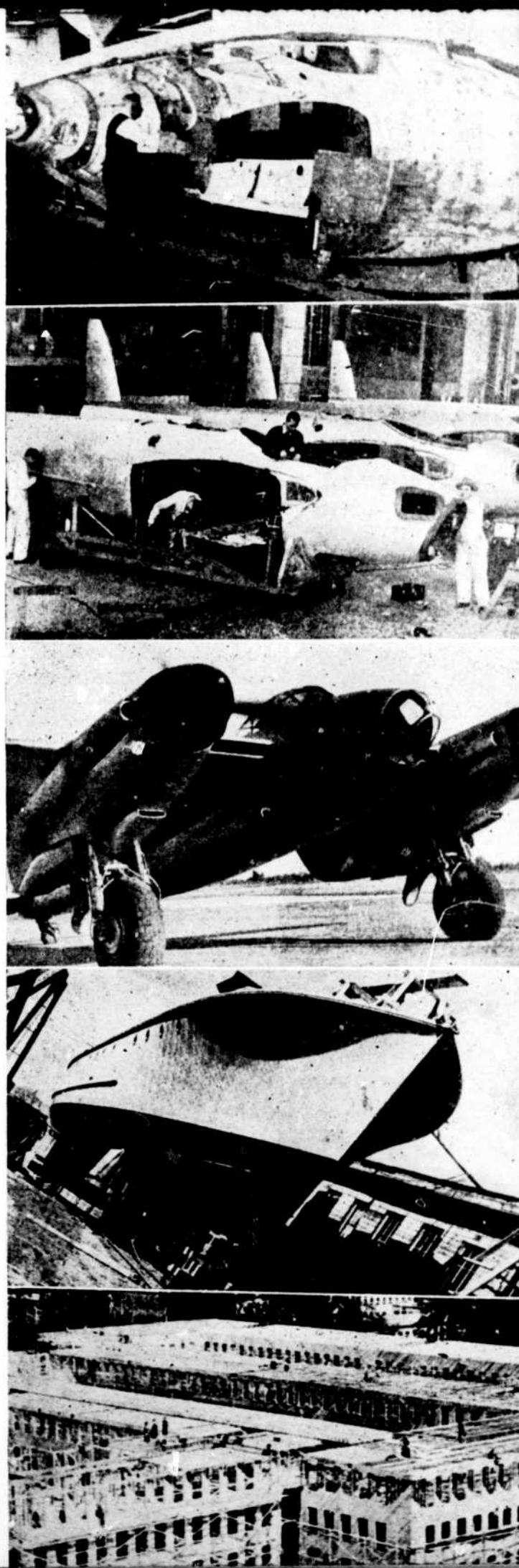
De haut en bas:—Nos 1 & 2: Détails sur la construction du superavion "Mosquito" entièrement réalisé en bois— 3: L'appareil en opération— 4: Une des nombreuses corvettes en bois construites au pays.— 5: Édifice de guerre complètement érigé en bois comme on en voit partout au Canada.
