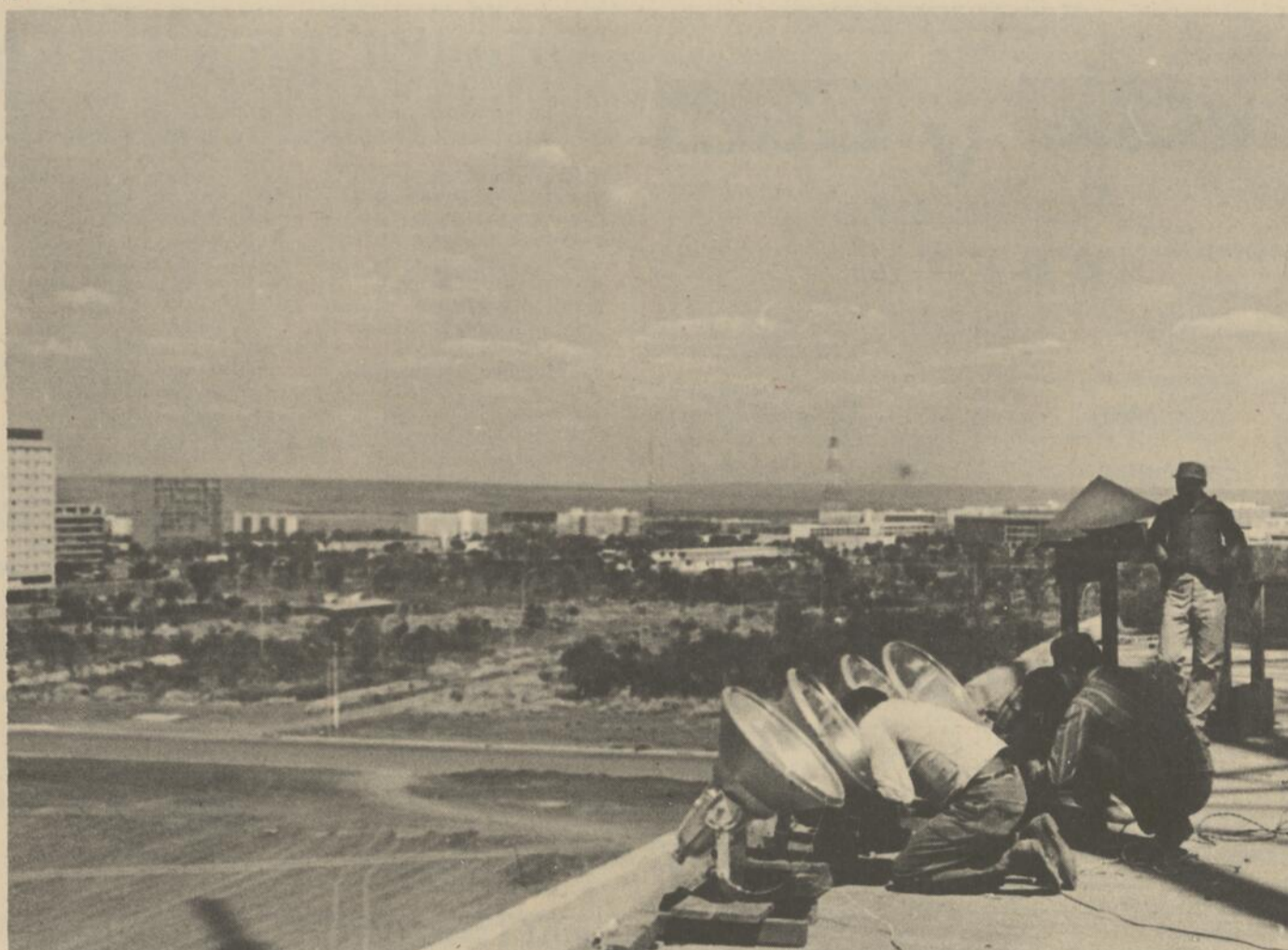
GRADUELLEMENT LEUR NOUVELLE CAPITALE. —On aperçoit ici des ouvriers en train d'installer les réflecteurs au sommet de la tour de télévision de la nouvelle capitale du Brésil, Brasilia. Bien qu'ils soient fiers de cette nouvelle ville, les Brésiliens ne se montrent pas très pressés d'aller s'y établir. De nombreux hauts fonctionnaires
