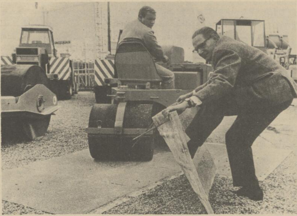
CES PLAQUES SPECIALES en matière plastique sont d'une solidité à toute épreuve et résistent à toute sorte de température. Elles servent principalement pour les travaux routiers. Toutes les machines de construction, quelles que soient leurs dimensions, peuvent rouler sur ces plaques. Un engin spécial conduit par un ouvrier met en moyenne 5 minutes pour achever 1 mille de route. La pose des plaques est facilitée par de longs clous. Plusieurs tests ont été réalisés pour vérifier la solidité des plaques. Les expériences ont été faites à Hambourg, en Allemagne.
