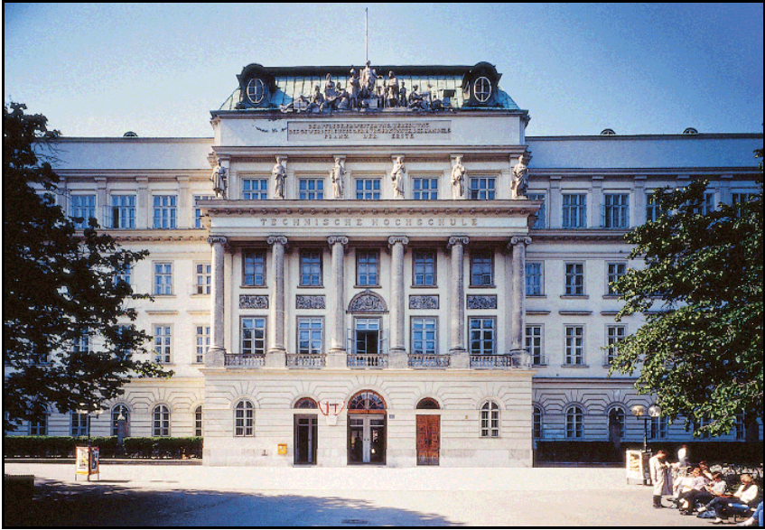
Figure 2.120: Main building of Technische Hochschule in Karlsplatz.
