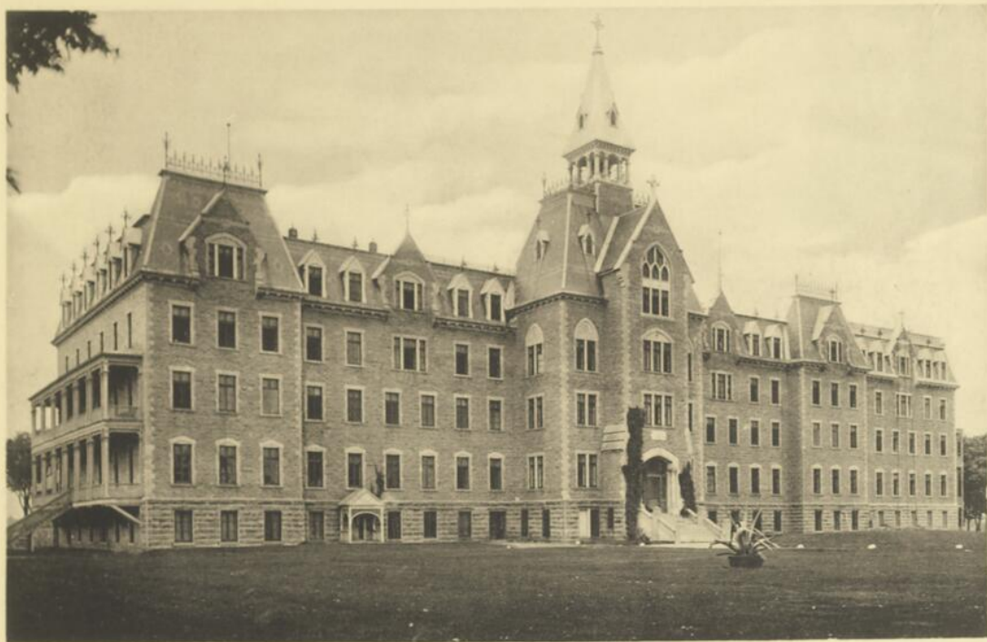
Façade, vue de l'Ouest
