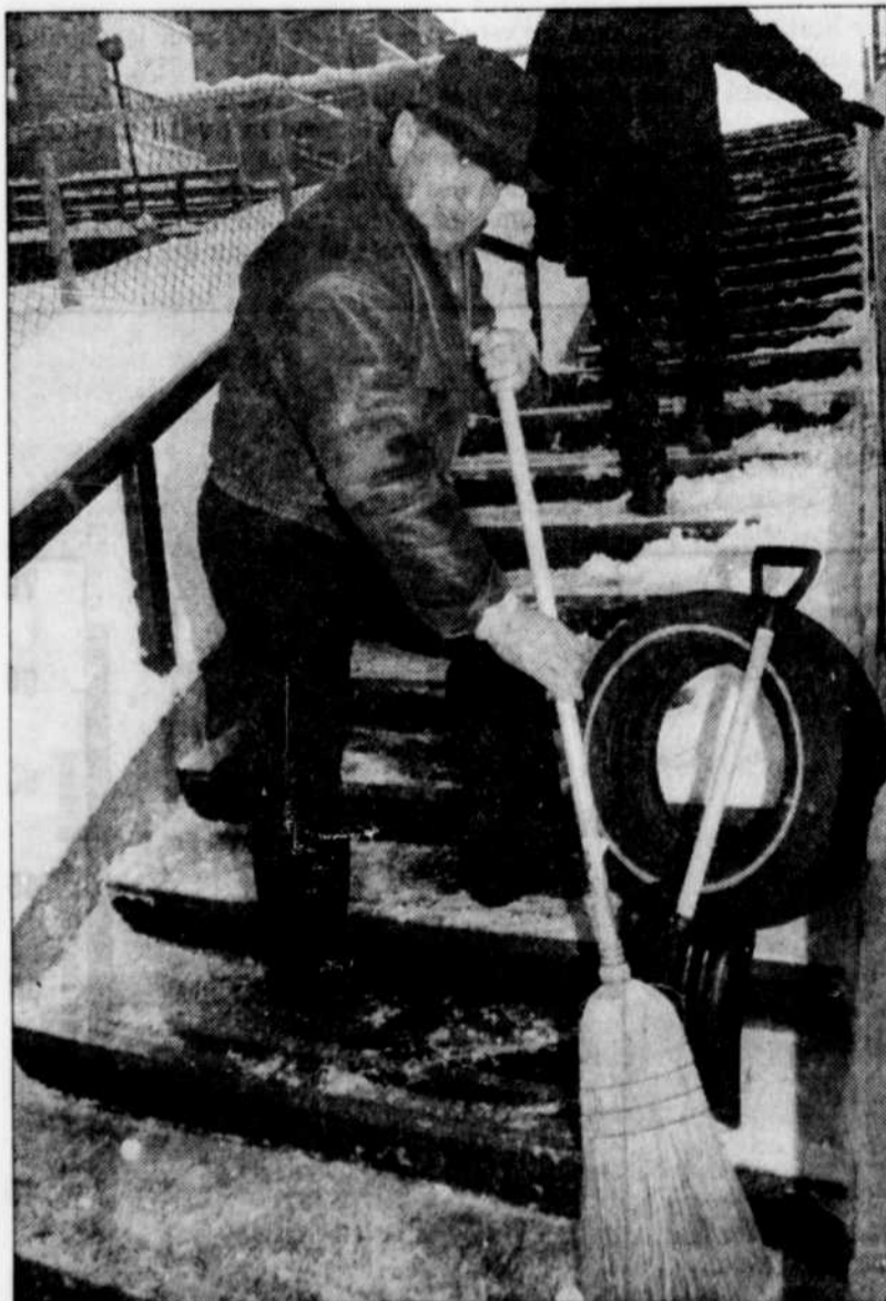
M. Jean-Roch Pageau dans un escalier de la rue Blouin, à Vanier. Il en coûte 6000$ pour une structure de ce genre (30 marches et deux piliers) et cela permet de récupérer 120 pneus de grandeur standard.
