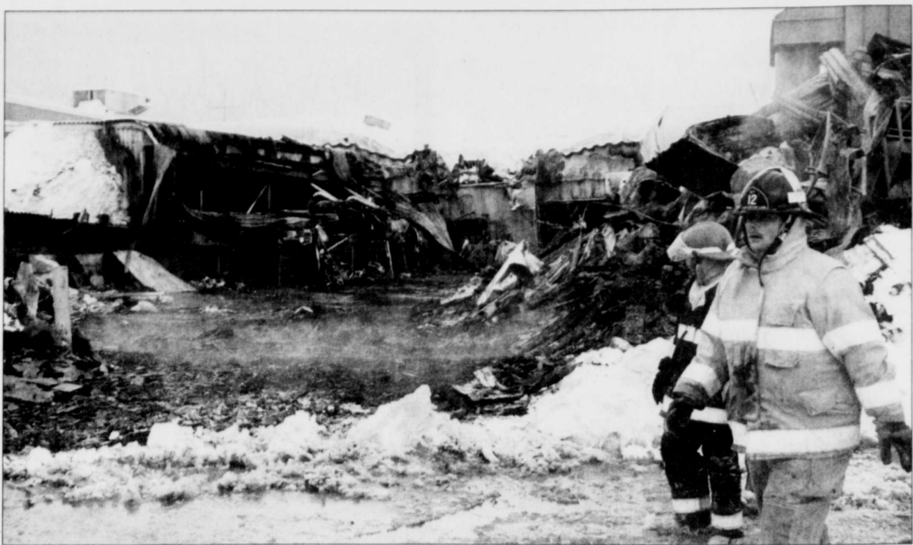
Une défectuosité électrique serait à l'origine de l'incendie qui n'a heureusement pas touché l'équipement technologique.
