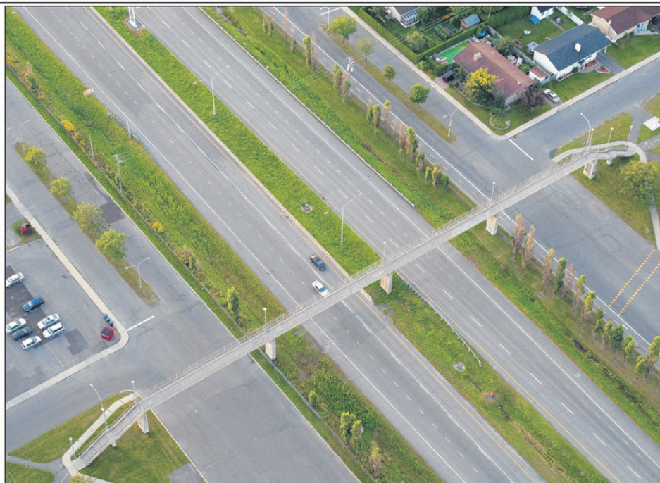
La passerelle qui enjambe l'autoroute 35, à la hauteur du boulevard de Normandie. Celle de Saint-Luc aura une conception plus raffinée.
