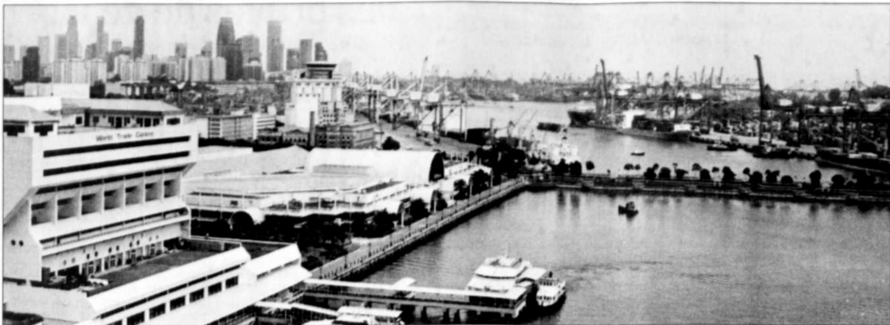
Les quatre terminaux du port de Singapour ont chargé et déchargé l'équivalent de 17 millions de conteneurs de 20 pieds en 2000. C'est 15 fois le volume qui transite à Montréal, le plus grand port canadien de conteneurs.
