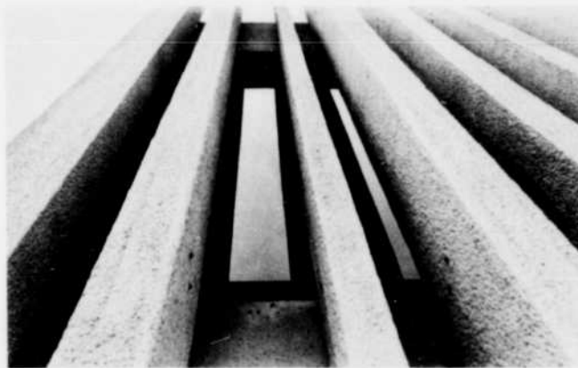
Photo 1 - Lames par-soleil en amiante-ciment.
