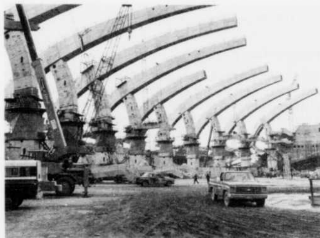
Figure 7 – Chantier olympique ; mât et consoles.
