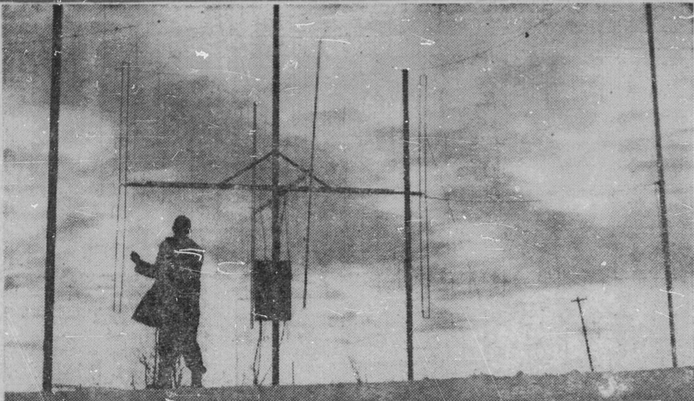
A l'occasion de l'année géophysique internationale, le Canada s'est vu confier des tâches bien spécifiques, dont celle de l'étude des aurores boréales. On voit ici l'antenne d'un appareil de radar utilisé pour capter le retour d'ondes radiophoniques lancées vers les aurores, permettant ainsi une étude continue, même pendant les longues journées polaires, de ces phénomènes qu'on retrouve principalement dans les deux hémisphères arctiques du monde.
