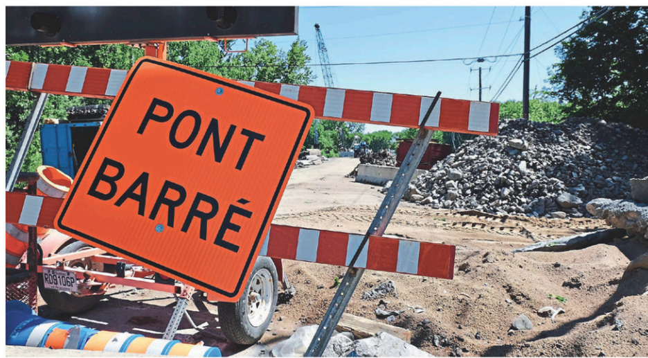
Les travaux de reconstruction du pont de la rivière Godefroy tirent à leur fin! Stéphanie Paradis
