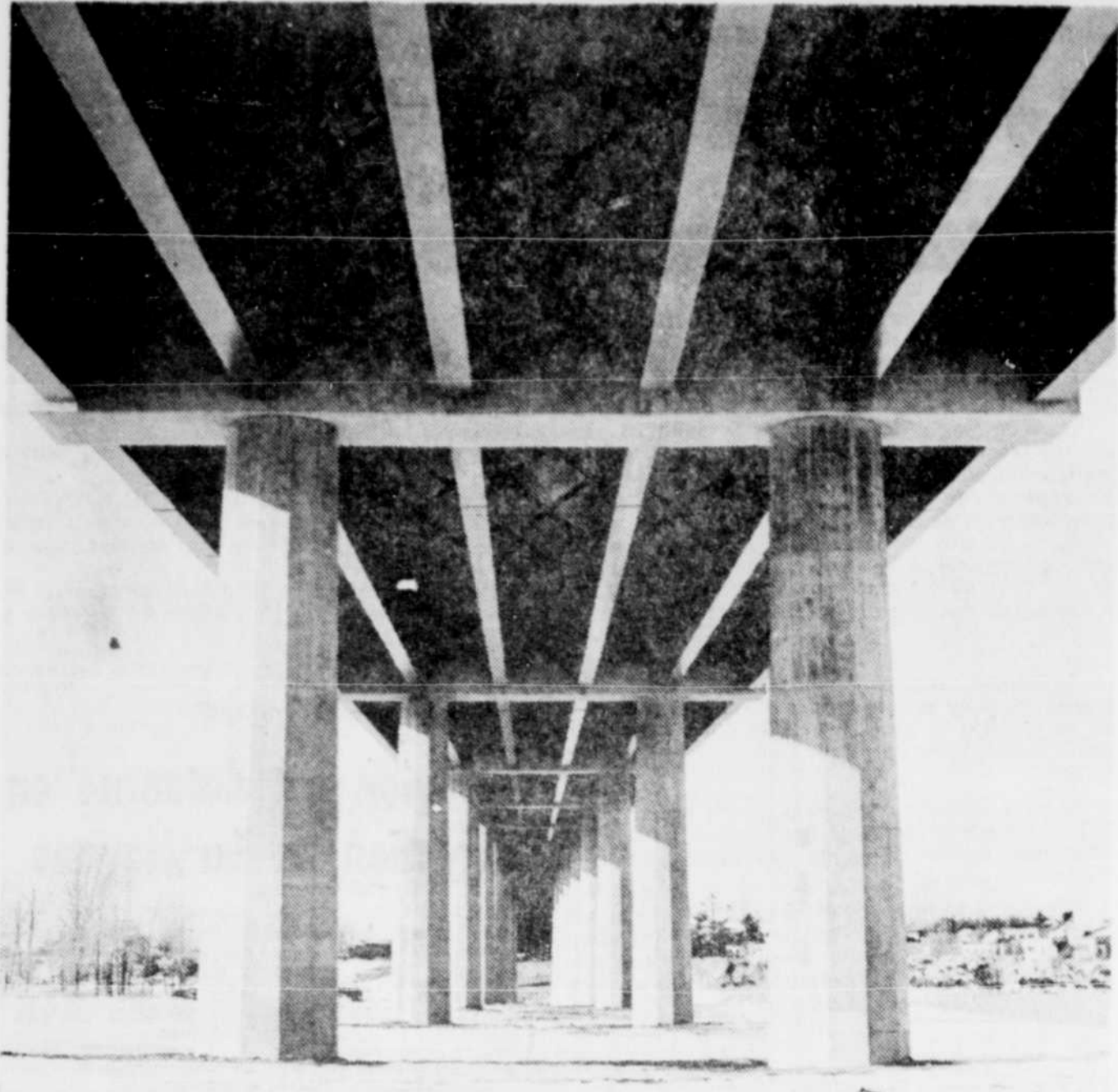
Les "dessous" du nouveau pont Sorel-Tracy
