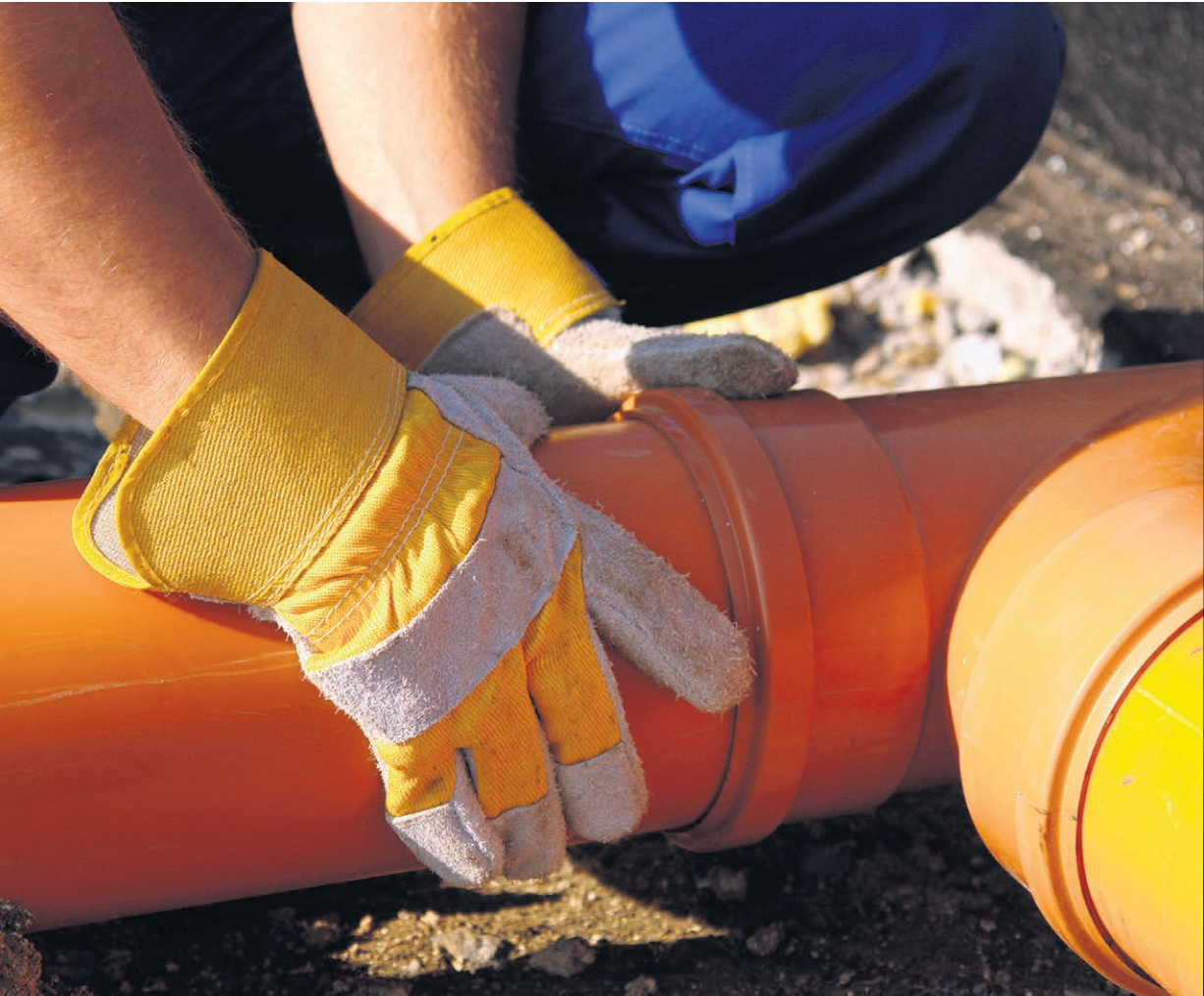
Les travaux de réparation de l'égout domestique se déversant dans la rivière de l'Achigan débuteront le 12 août prochain.
