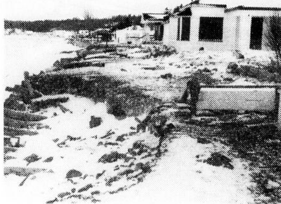
L'hiver n'a pas tardé à faire sentir sa présence. Une première tempête le 7 décembre causait plusieurs dégâts dans la région.
