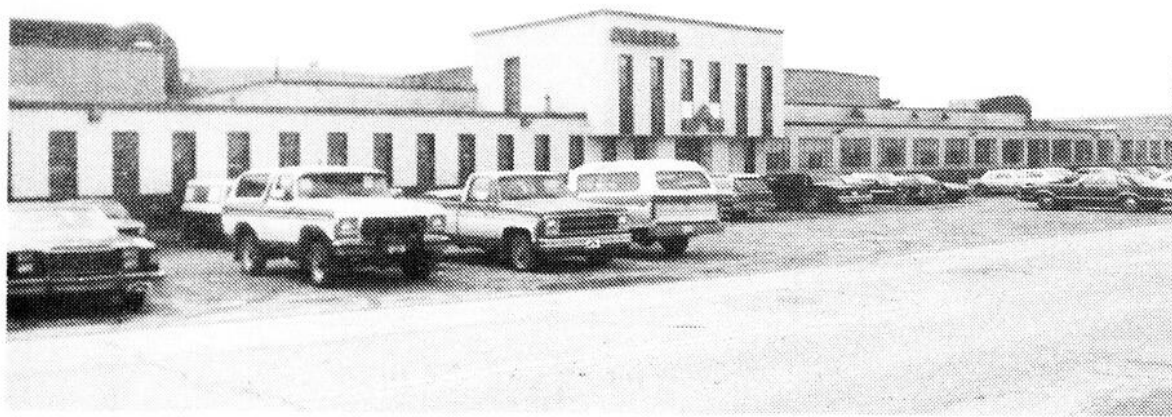
La compagnie Sométal de Rimouski, une division de Marine Industrie, s'est vu octroyée en avril un contrat de 23 millions de dollars pour la fabrication, la livraison et le montage d'équipements hydromécaniques devant servir à la construction d'un barrage en Afrique.
