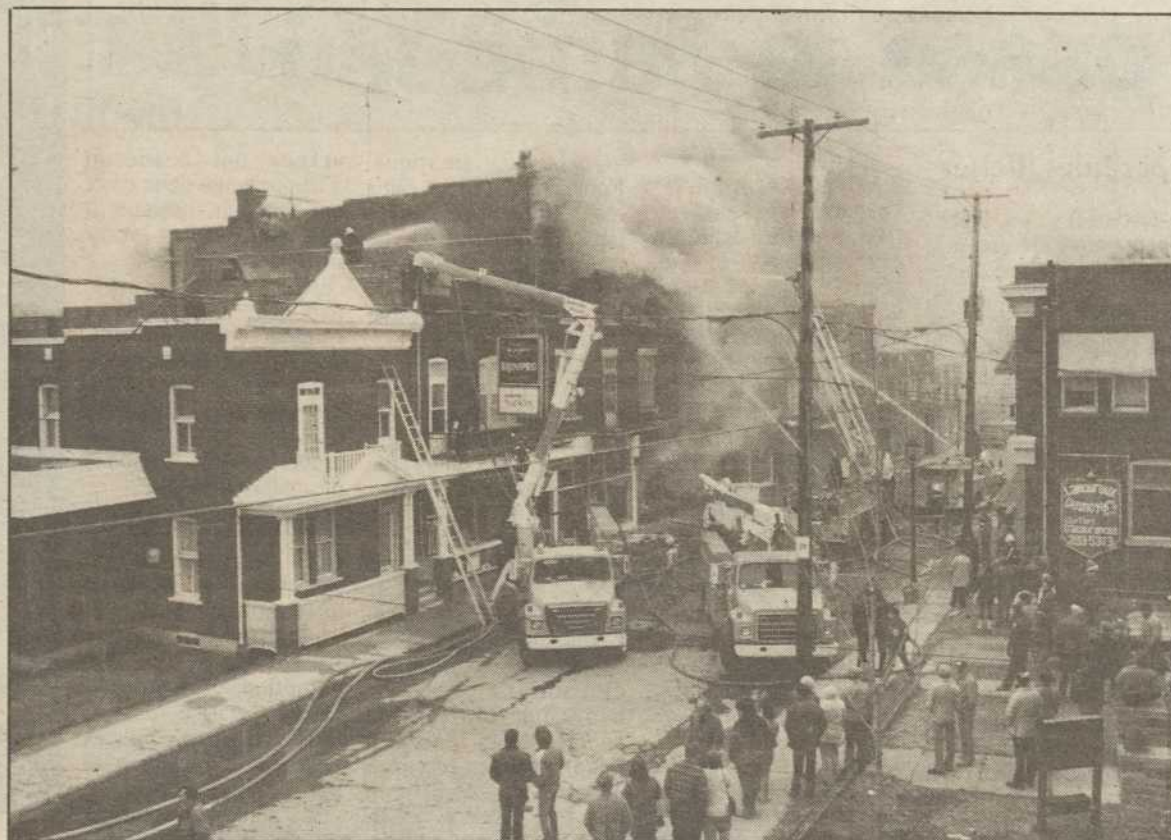
Un nouvel édifice devrait être construit sur le terrain laissé vacant par l'incendie qui a détruit cet immeuble du centre-ville de Farnham en avril dernier.
