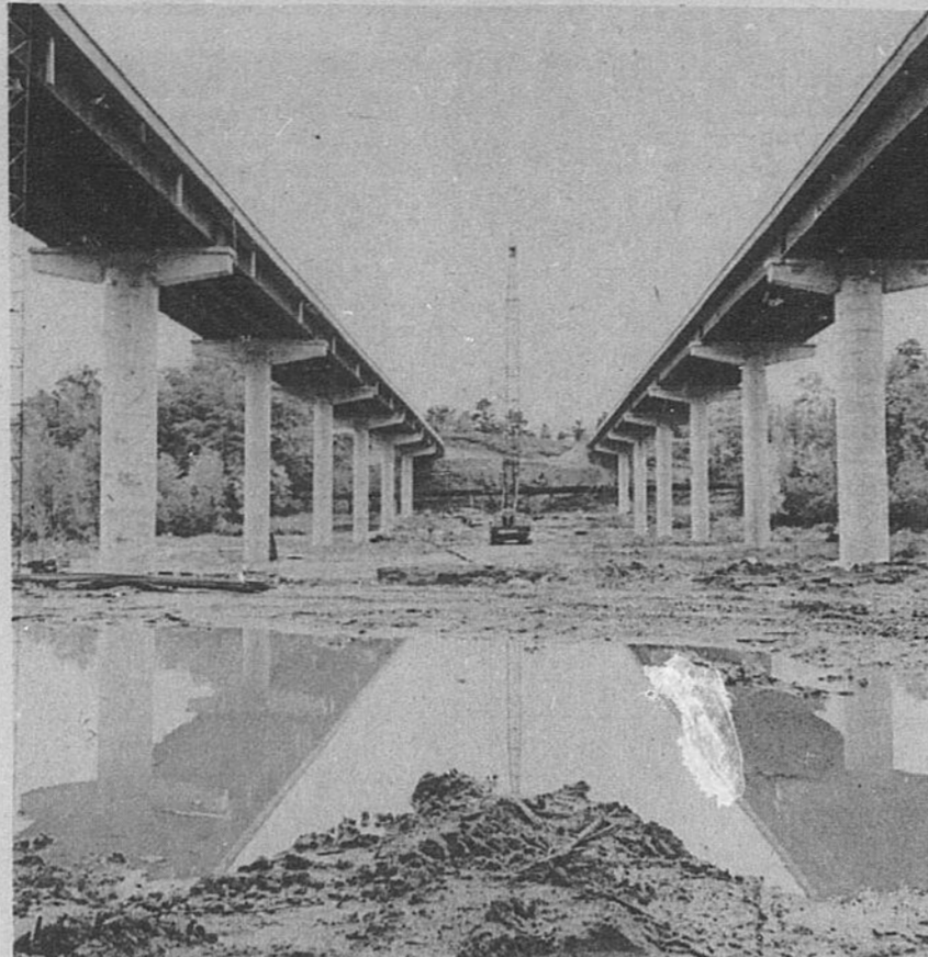
L'autoroute 50: viaduc à Masson
