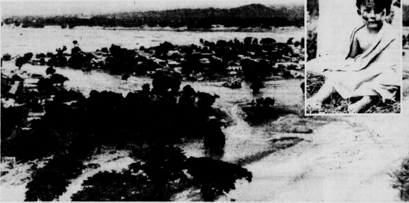
Un océan de boue recouvre la ville d'Armero. Un garçonnet a miraculeusement échappé à la noyade, des sauveteurs l'ayant retiré de sa maison engloutie.
