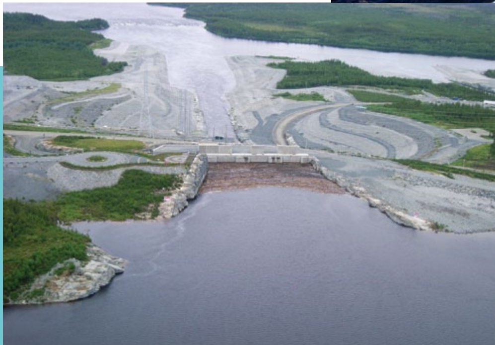
Débris ligneux devant la prise d'eau de la centrale de l'Eastmain-1
