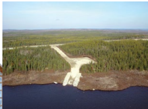
Rampe de mise à l'eau
