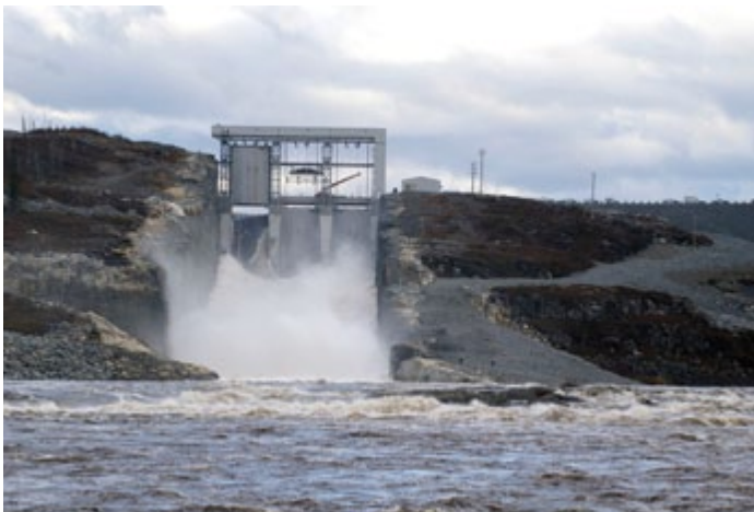
Évacuateur de crues vu de l'aval
