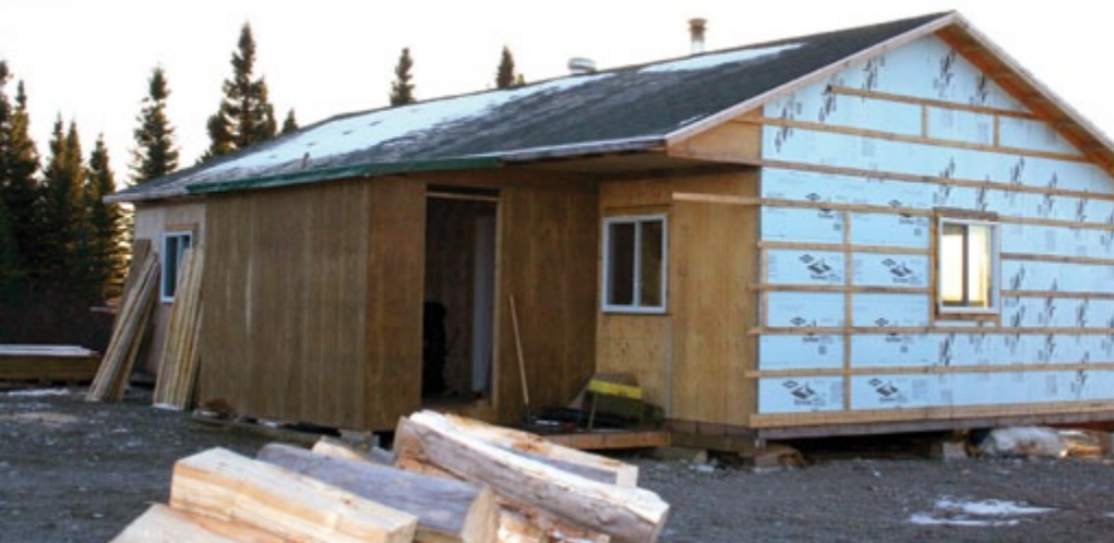
Camp en construction au lac Mitsumis
