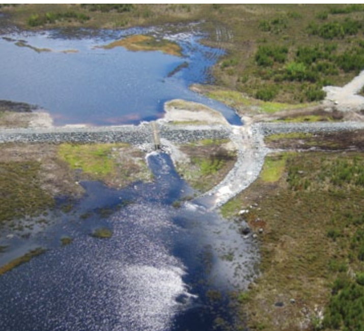
Digue et entrée de la passe migratoire dans la baie BE-07
