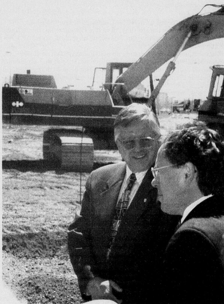
Le président de la SAQ, Jocelyn Tremblay, à gauche, et le maire de Hull, Yves Ducharme, ont procédé au lancement des travaux du nouveau magasin, près du Casino.
