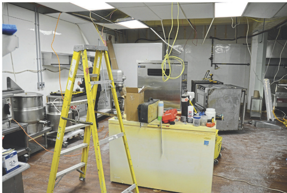
Des travaux sont en cours dans la cuisine de l'organisme. (Photo: Journal Le Guide - Xavier Demers)
