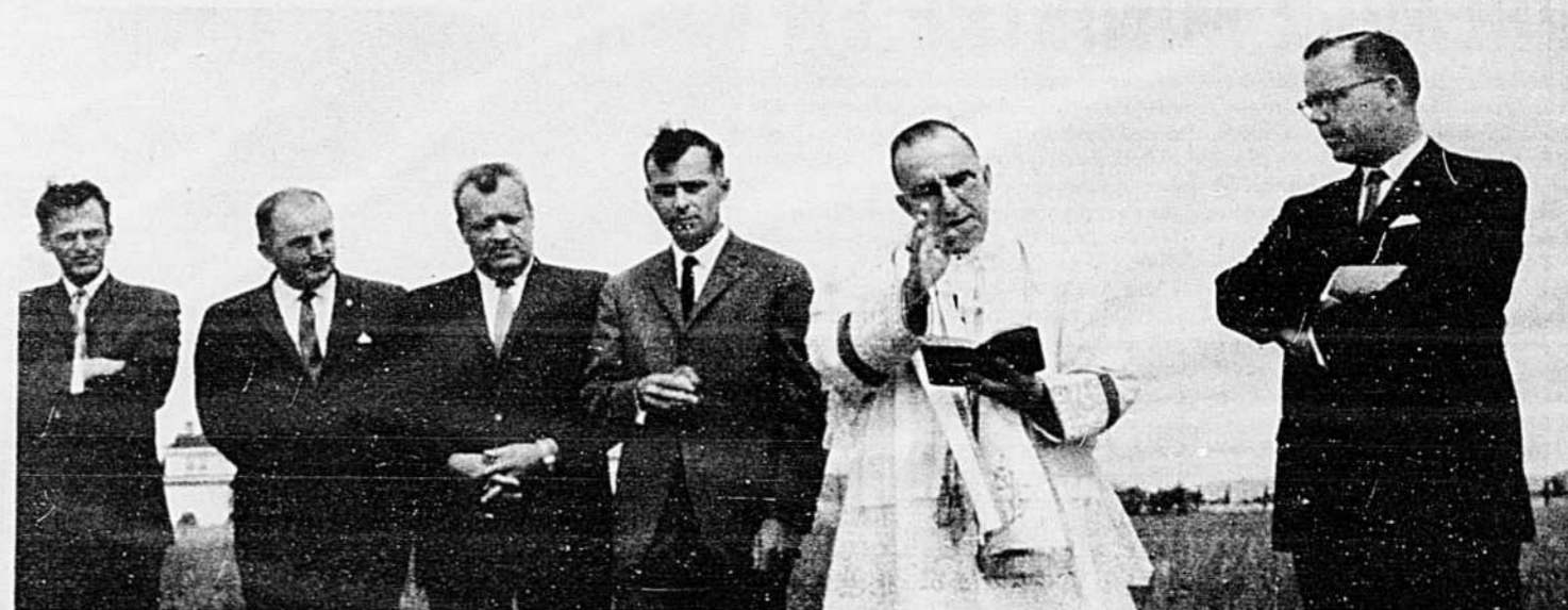
M. le Chanoine Paul Labelle, curé de la Cathédrale bénissant les travaux de l'usine de filtration. A sa droite M. Robert Desjardins, maire de la Cité et de gauche à droite, MM. Charles Ouellette, Laurent Girouard, ingénieur conseil, Roland Lauzon, échevin et Roland Verreault, ingénieur en chef de la Cité de St-Jérôme.
