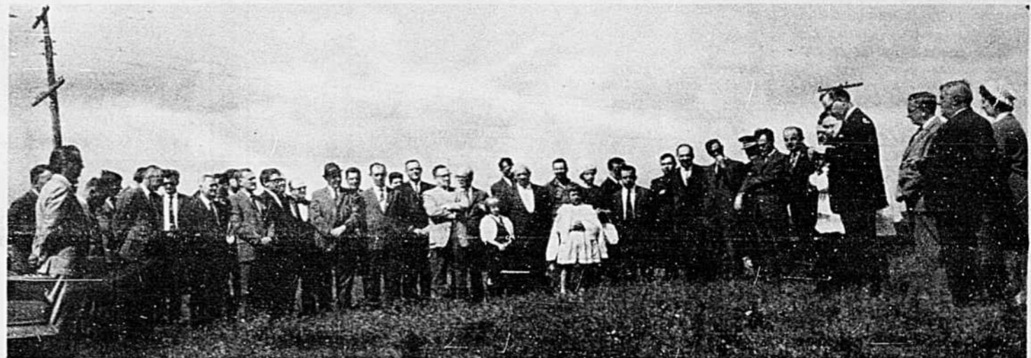
Les invités à la bénédiction des travaux de l'usine de filtration. On voit M. le Maire prononçant l'allocution d'usage.
