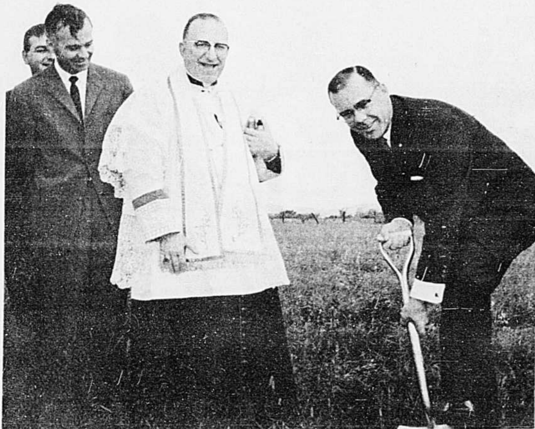
Geste symbolique: la levée de la première pelletée de terre à l'endroit où sera construite l'usine de filtration. Ici S.H. le maire Robert Desjardins exécutant ce geste en présence de M. le chanoine Paul Labelle et des ingénieurs Verreault, Whissel.
