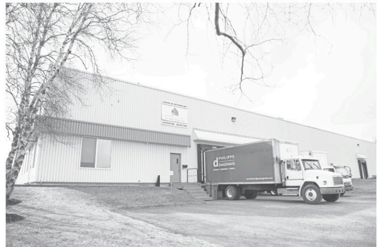
Encore récemment, une offre d'emploi avait été affichée pour un poste de commis d'entrepôt au centre de distribution installé dans le parc industriel de Granby.
