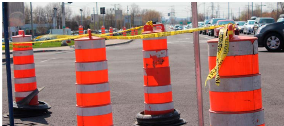
Le MTQ procédera à des travaux de reconstruction de ponceaux sur la 116 à Saint-Bruno. (Photo : archives)
