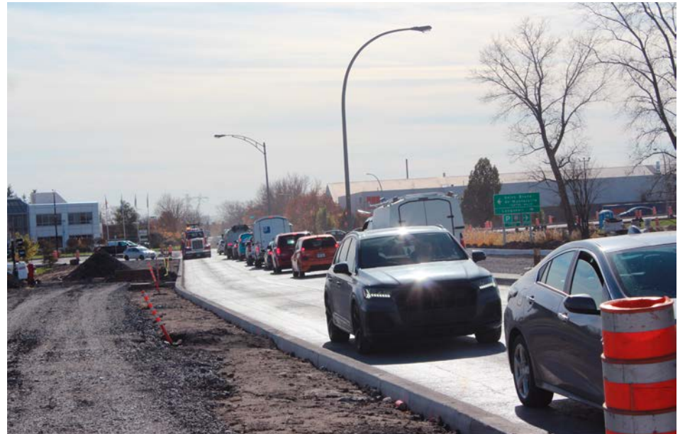
Les travaux sur Marie-Victorin avaient causé des problèmes de circulation l'été dernier. (Photo : archives)
