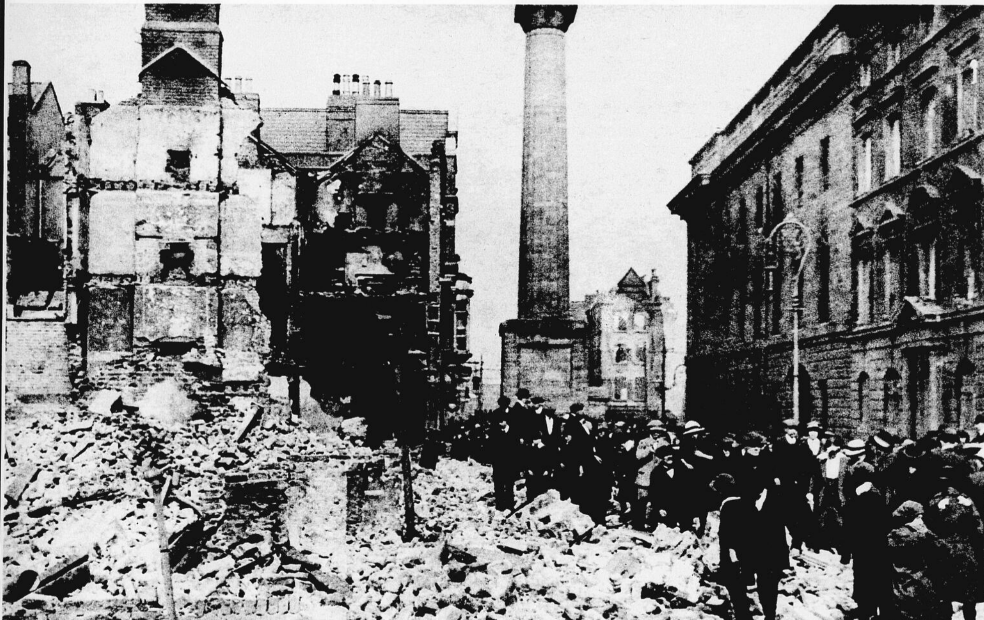
Vue de la rue Henry, à la fin des combats. Au fond, la colonne Nelson, qu'on a fait sauter récemment.
