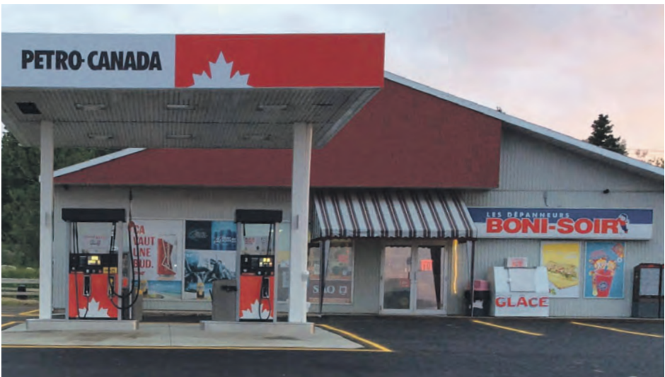
L'Épicerie Steeve Gagné de Baie-Trinité procédera à l'installation d'une génératrice. Photo courtoisie
