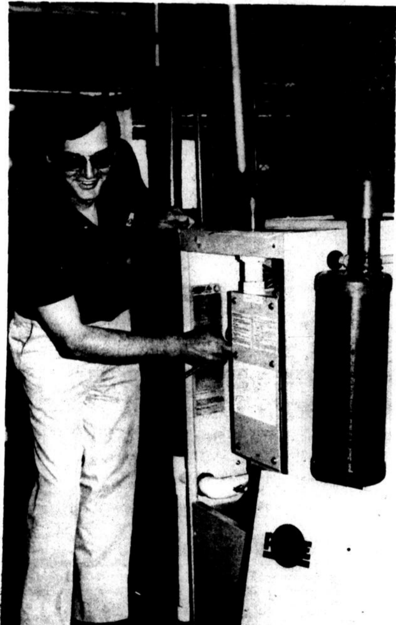
M. Jean-Pierre Martin, professeur de plomberie et chauffage à la Polyvalente Le Boisé. On voit ici M. Martin procédant à une vérification de la fournaise à gaz naturel de la troisième génération. Cette fournaise à gaz naturel se veut une première à Victoriaville.
