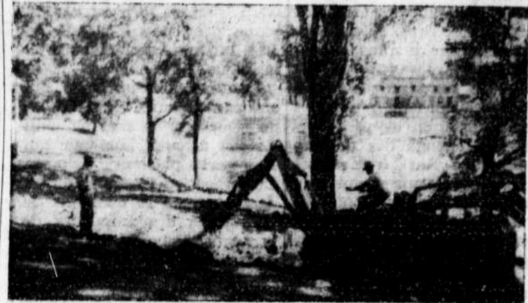
Les travaux d'installation d'un système électrique dans le parc de l'avenue Saint-Louis vont bon train. Nous voyons ici l'échevin Antonio Daunais qui s'est fait le champion de ce projet, à gauche, surveillant l'opérateur de la machine à creuser, M. Jean-Paul Quevillon.
