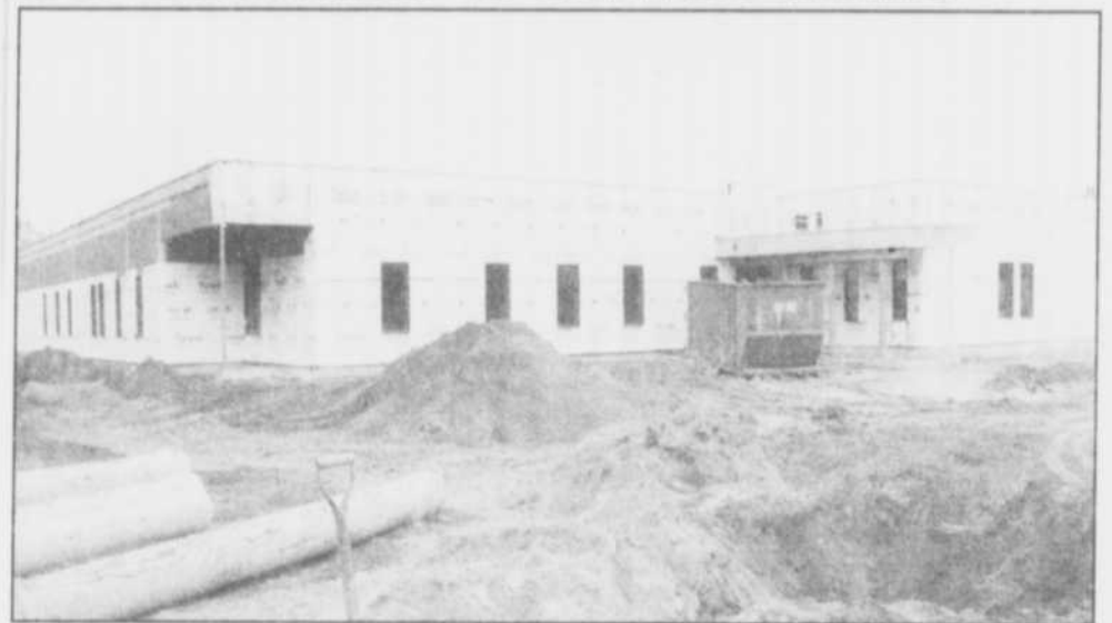
Le nouveau centre Le Bouclier actuellement en construction sur la rue Masson à Terrebonne, secteur Lachenaie. (Photo : La Revue)
