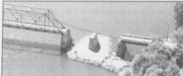
Le pont Préfontaine-Prévost, mieux connu sous le vocable "vieux pont de Terrebonne", rouvrira au plus tard à la mi-novembre. (Photo: Jean-Daniel Cossette, Point du jour aviation)
