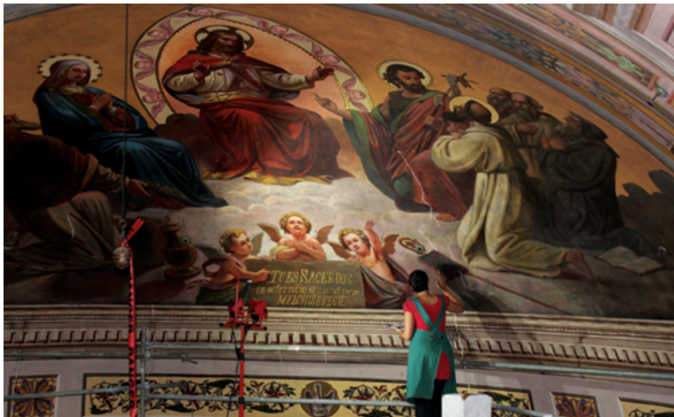
Retouches sur les comblements des fissures dans le chœur de l'église de Saint-Romuald Photo : Michael O'Malley
