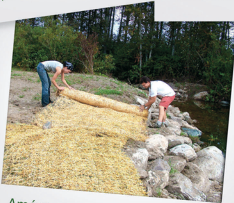
Aménagement de berges Comité de restauration de la rivière Etchemin, 2005
