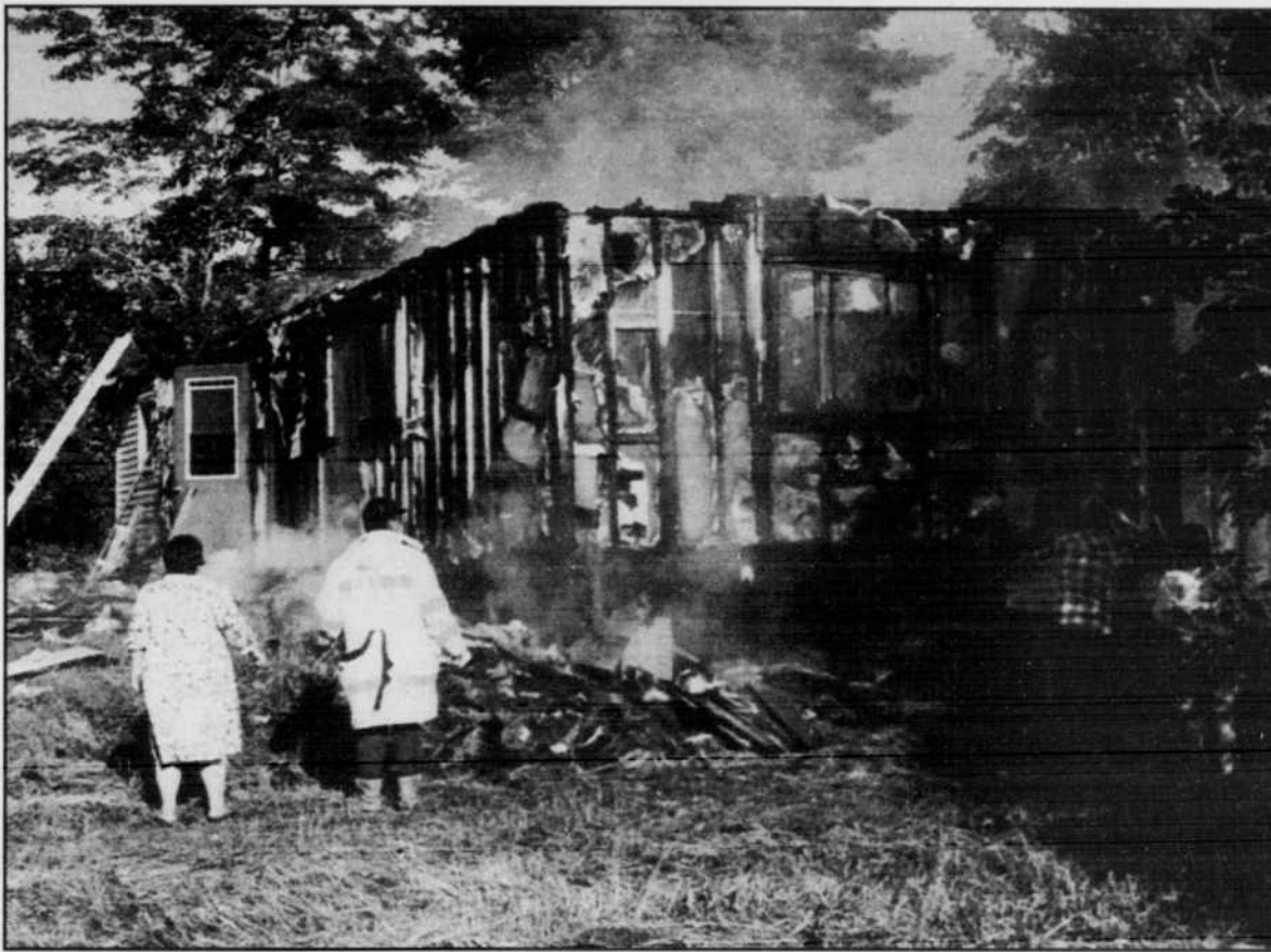
Frappée par la foudre, cette roulotte de Brigham a été complètement détruite.
