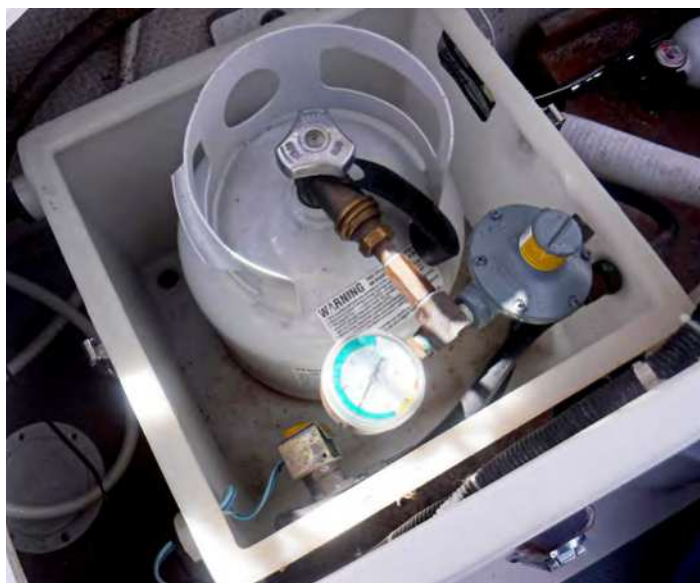
Installation d'un compartiment de propane.
