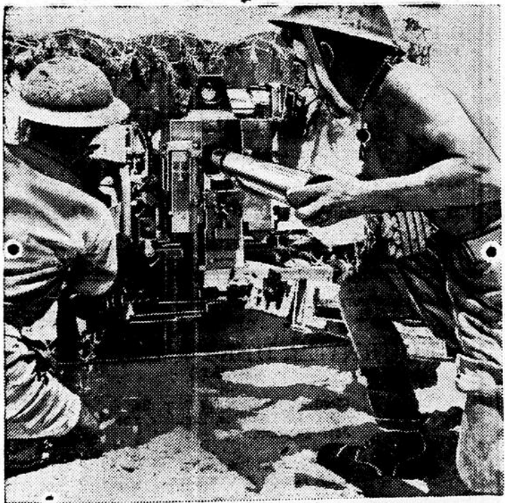
Le canon antiaérien de 6 livres a joué un rôle important dans la victoire britannique contre les forces de Rommel au Moyen-Orient. Cette pièce, qui a remplacé celle de 2 livres, possède une portée supérieure au 16mm, allemand et lance un projectile plus lourd. Servi par une équipe bien entraînée, comme celle que l'on voit sur cette photo, le "6 livres" tire aussi très rapidement.
