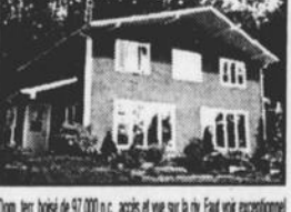
34 Maison rénoverée, secteur Parc Bellevue
