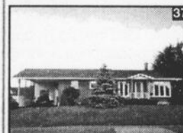
37 Maison. réc. couverture, châssis, armoire, plancher
