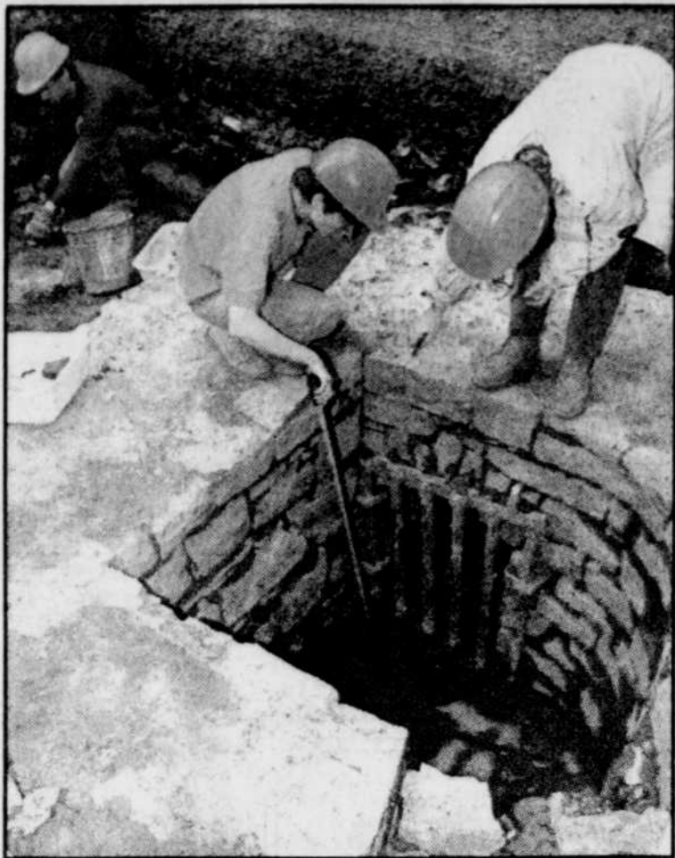
Les latrines de l'ancienne prison ont des barreaux de métal qui permettent l'écoulement de l'eau mais empêchent la fuite des détenus. C.
